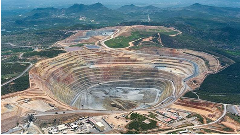
Şekil 2: Madencilik uygulamaları ekosistemde onarılması zor hasarlar oluşturmaktadır
